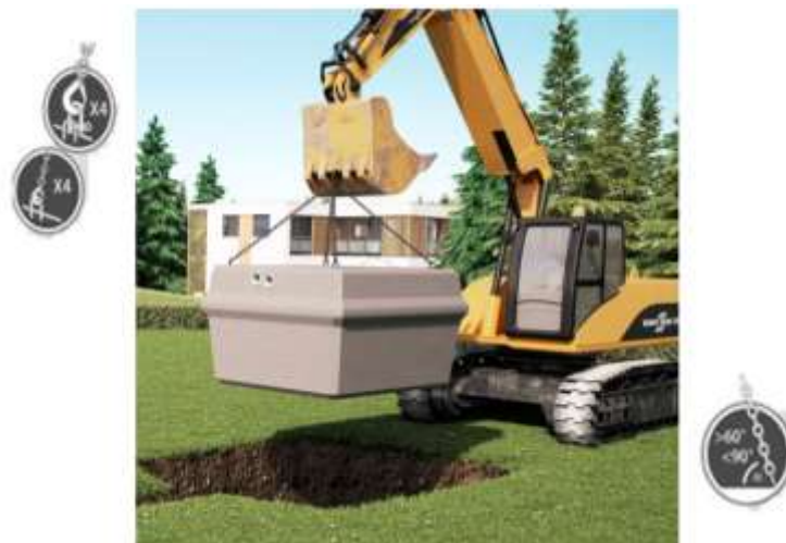
Fig-15 : Manutention de cuve
