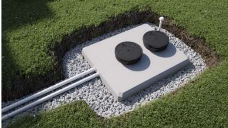
Fig-23 : Remblaiement
